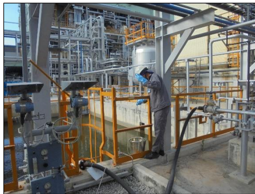
รูปที่ 4.5 การเก็บตัวอย่างคุณภาพน้ำทิ้ง บริเวณ Cooling Water Blowdown Hold Sump
